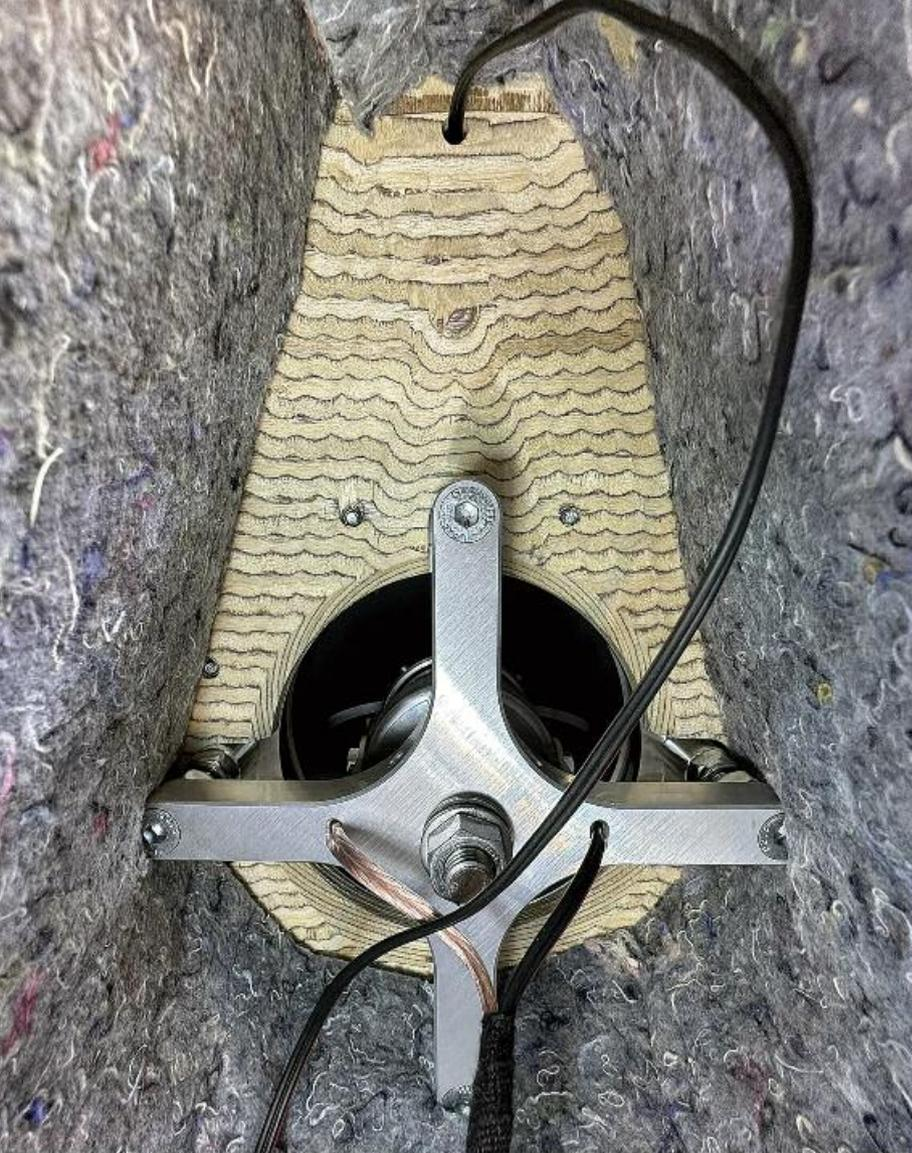
Links: Der hochkomplexe, vielschichtige Aufbau des Gehäuses aus Birke Multiplex in Marinequalität. Schichten von CNC-gefrästem Sperrholz werden per Hand aneinandergesetzt und verklebt. Das massive Metallkreuz ist der Korb, an dem der LEMS-Antrieb für den frei beweglichen Tief-Mitteltöner befestigt ist
